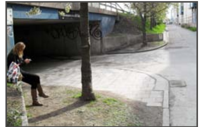
Stödmuren fungerar som sittplats, markbeläggningen varierar. Trottoaren i tunneln är kort och har en abrupt övergång.
