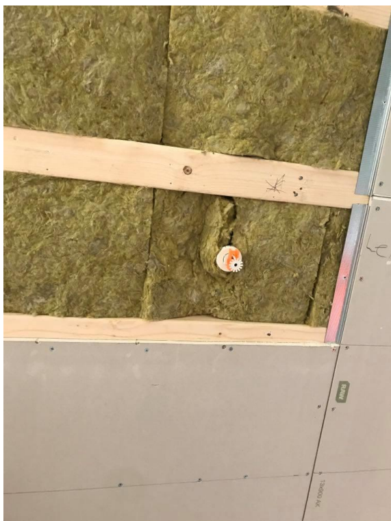
Figur 5 Sprinklerhuvud i snedtak. Författarnas egentagna foto.
