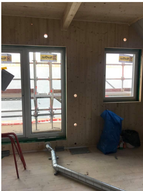
Figur 4 Yttervägg som kommer förbli exponerad (golv och tak kommer att kläs med gips). Författarnas egentagna foto.
